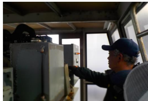
【予備原動機切替訓練】
